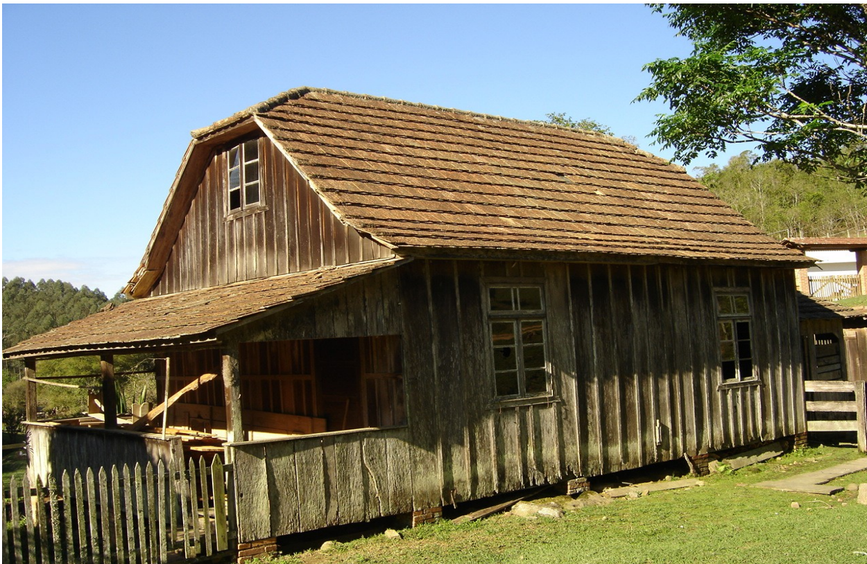
FOTO DA FACHADA LATERAL
